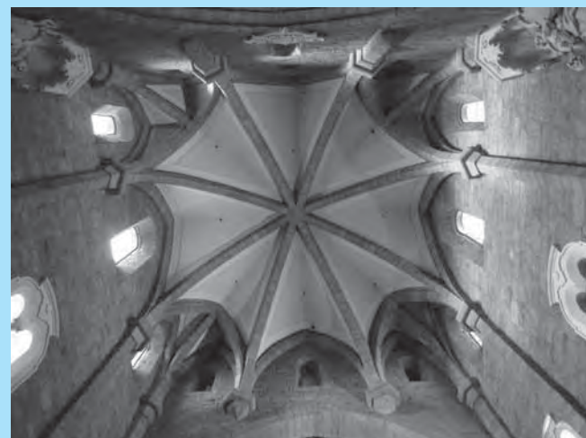
Obr. 13 Pohľad na osemdielnu klenbu vo svätyňi třebského kláštorného kostola – Baziliky sv. Prokopa. Foto: internet.
