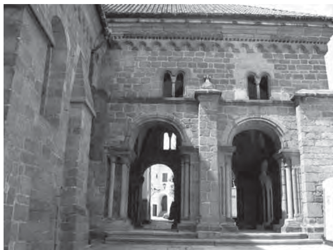
Obr. 10 Severná predsieň třebského kláštorného kostola – Baziliky sv. Prokopa. Foto: archív autorky.
